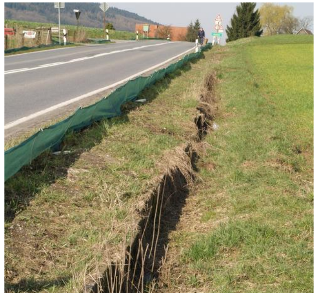
Amphibienzaun an der Haller Str., davor die alte verfallene Leiteinrichtung (Bild von 2006)
